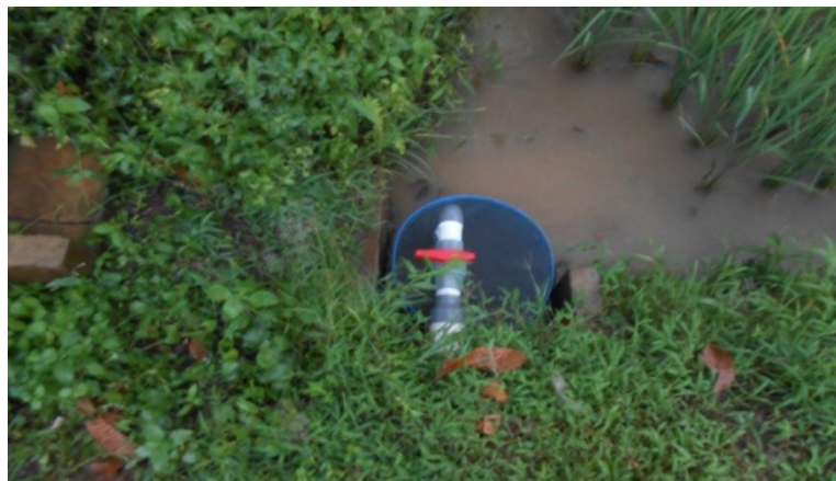
Gambar 6. Pemasangan Keran dan Pelampung pada Bak Air
